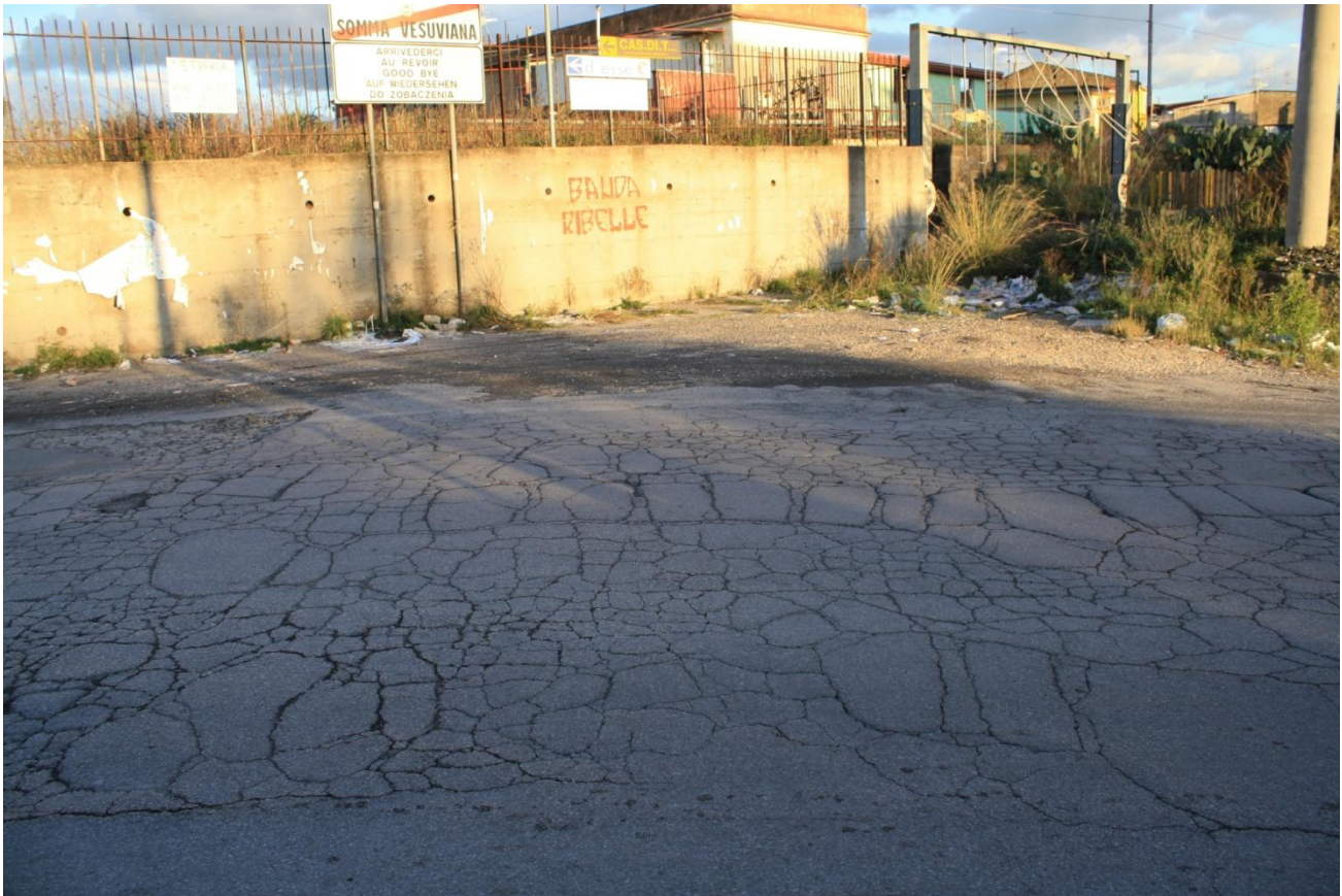
Stato della pavimentazione stradale su Via Cupa di Nola
